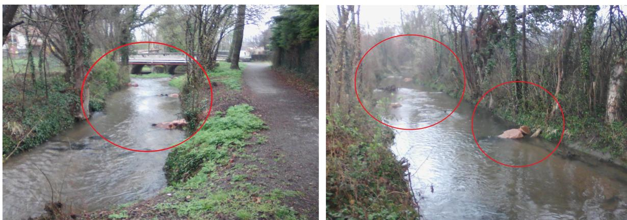
Illustration 28 : Exemple de déflecteurs (blocs) sur l'Auzon dans le Puy-de-Dôme (Géonat)
