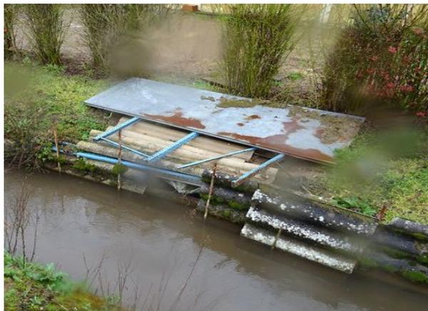
Illustration 30 : Protection de berges inadaptée sur le Pontou (Géonat)
