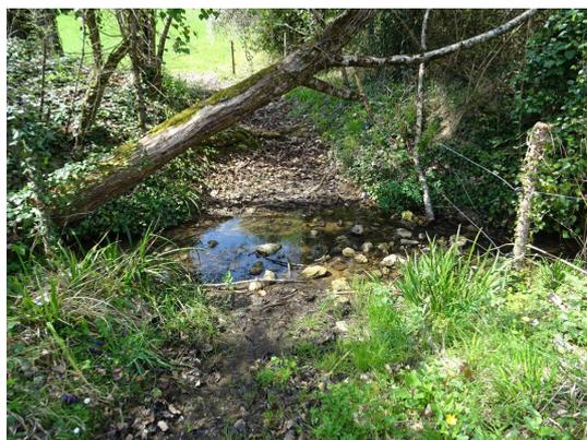
Illustration 17 : Passage à gué dégradé et non stabilisé et absence de mise en défens sur le Peyrat (Géonat)
