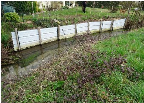
Illustration 29 : Protection de berges inadaptée sur le Moulant (secteur du Moulinal, Géonat)
