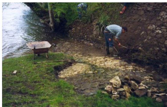
Dégagement de la cale en 1999
