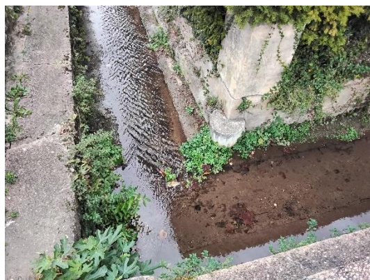
Artificialisation du lit du Thouron dans Cénac
