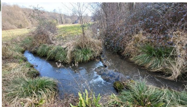
Répartition (incontrôlée) des eaux en amont du moulin de la Borie
