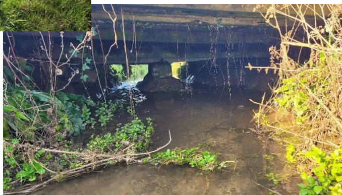
Passerelle référencée au ROE, amont du moulin Caillou
