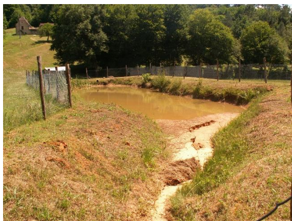
Le bassin de décantation du circuit automobile de Bonnet et sa surverse en arrière-plan
