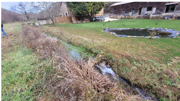
Le petit bassin d'eau et le barrage de fortune en pierres, on aperçoit la prise d'eau en amont.
