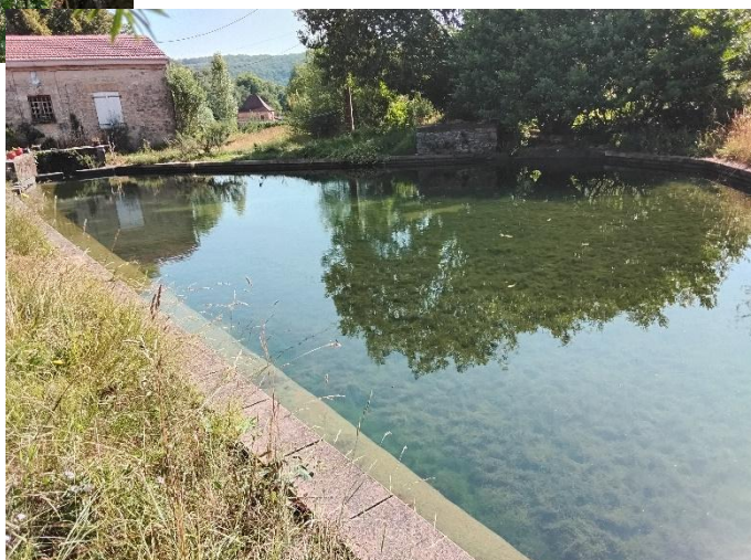
Bief et ancien moulin de Terret.
