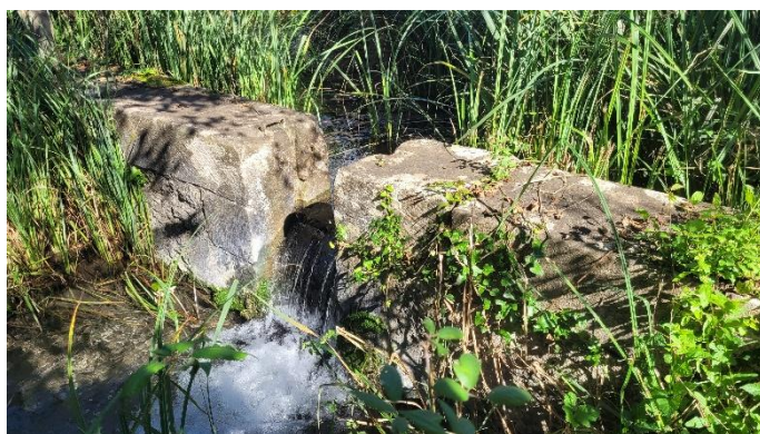
L'un des trois ouvrages bâtis servant autrefois de barrage pour l'irrigation
