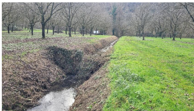
Vue générale vers l'aval, ruisseau linéaire dépourvu de ripisylve
