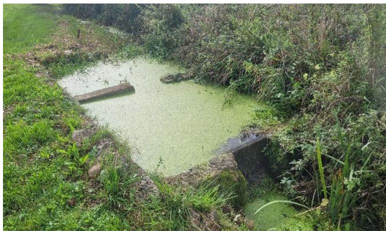
Lavoir bâti dans le lit du ruisseau
