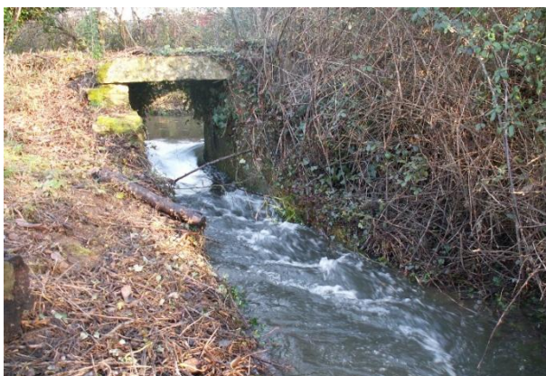
Surverse et rampe inclinée du bief du moulin du Moulinal
