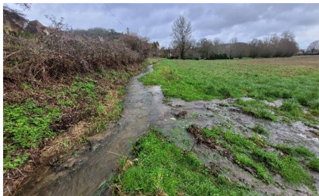
Secteur de sédimentation et colmatage du Merdassou en amont du collège de Saint-Cyprien
