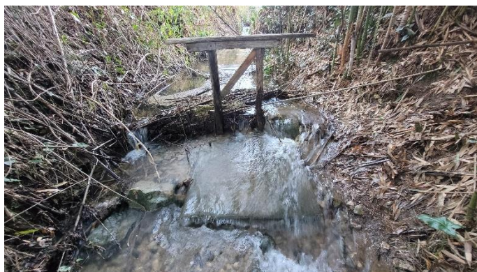
Ouvrage indéterminé dans le lit mineur du Conty
