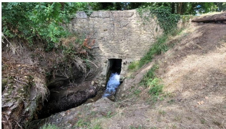
Pont bâti juste avant la confluence, malgré un gabarit réduit, des cyprinidés fréquentent le ruisseau lors des montées d'eau de la Dordogne.
