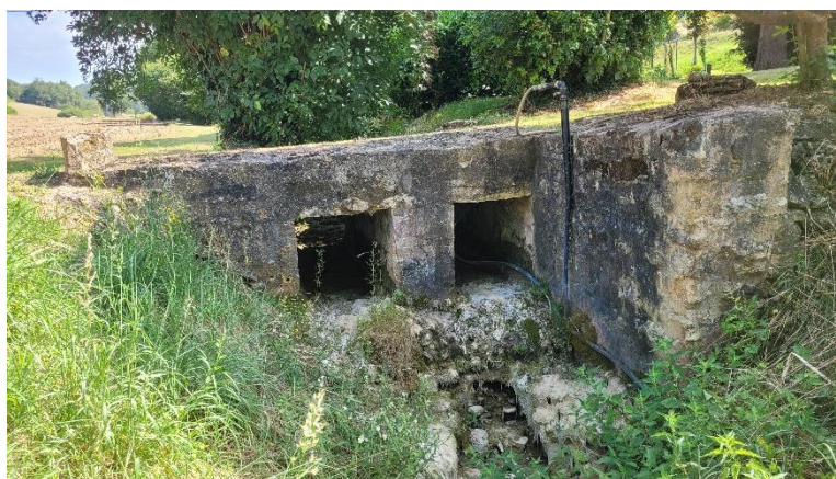
Ouvrage de traversée d'un chemin privé, dalot double
