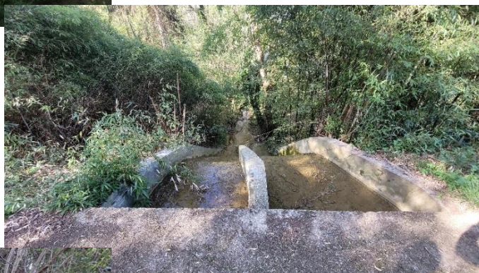
Rampe inclinée bétonnée en sortie de l'étang aval du Bos
