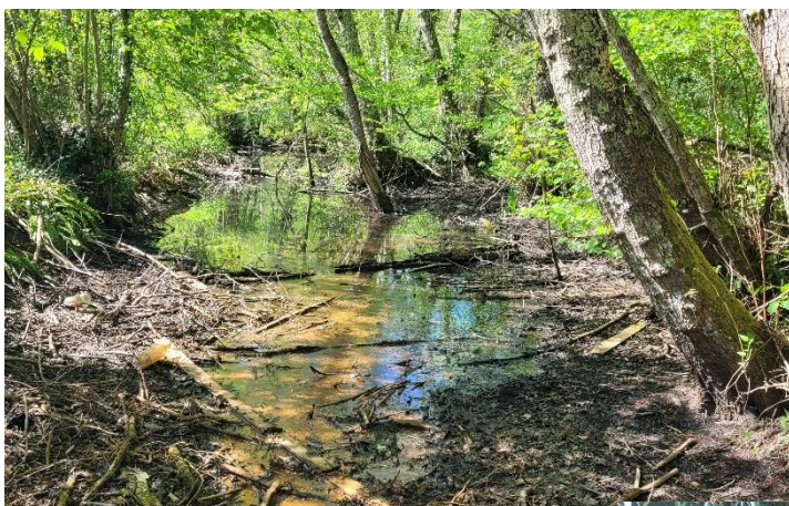
Aperçu de l'étang aval, encombré de nombreux bois morts et déchets divers
