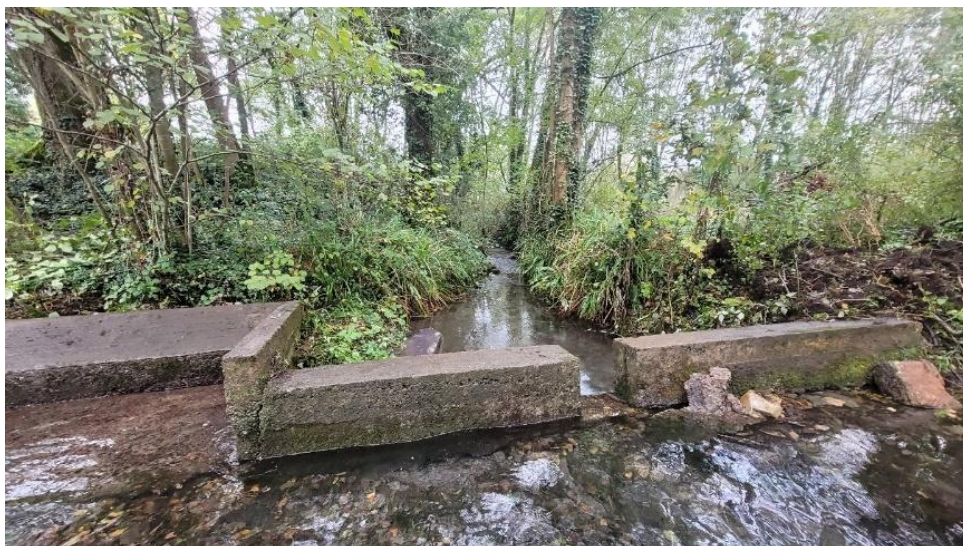
Lavoir - répartiteur, aval de Vivier.
