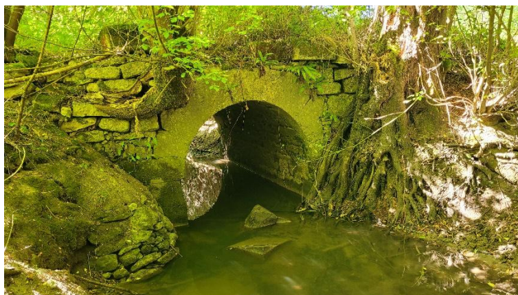
Ouvrage en pierre abandonné, Brande aval.
