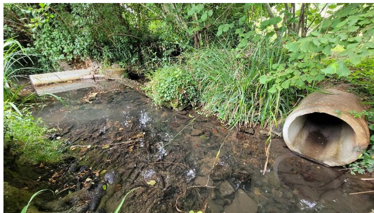
Le Peyrat médian, buse de restitution de l'étang du Gouzot et répartiteur du moulin du Bourg.
