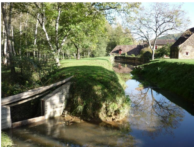
Ouvrage bloquant (répartiteur à gauche) au moulin du Pressoir.
