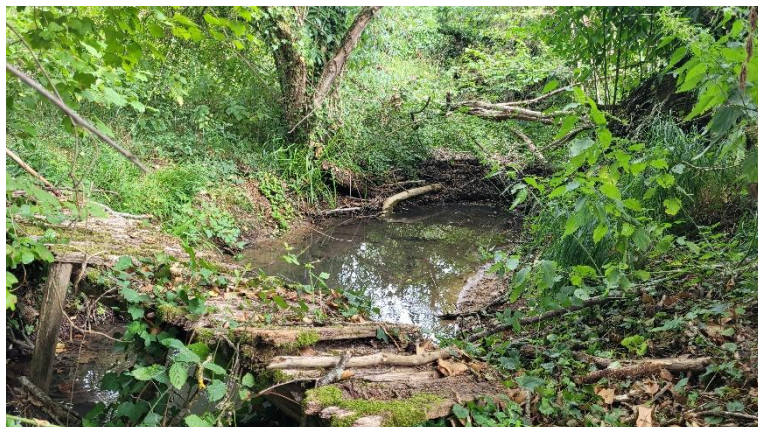
Ancienne passerelle en bois abandonnée et embâcle en aval, moulin du Pic.
