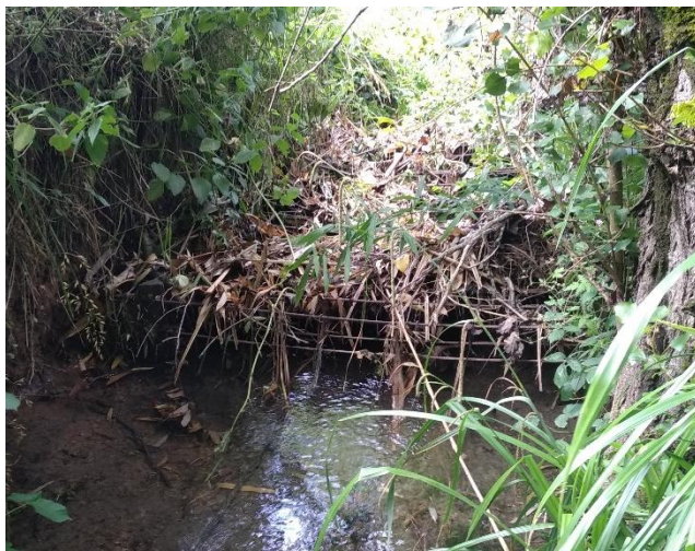
Grillage de protection contre la faune sauvage, formant obstacle à l'écoulement en lit mineur, jardin de bambous de Planbuisson
