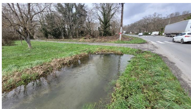
Le But aval, impacté par les montées d'eau de la Dordogne à Vic
