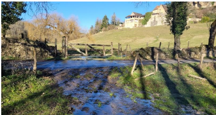
Buses colmatées en sortie d'étang avec débordement sur la route
