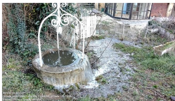
Débordement du puits vers l'habitation
