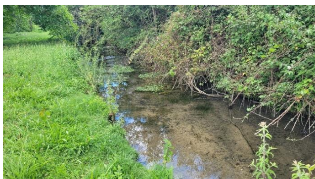
Exemple de surlargeur occasionnant une sédimentation
