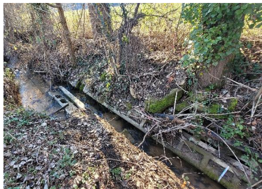
Poteaux en béton dans le lit mineur, amont de la confluence
