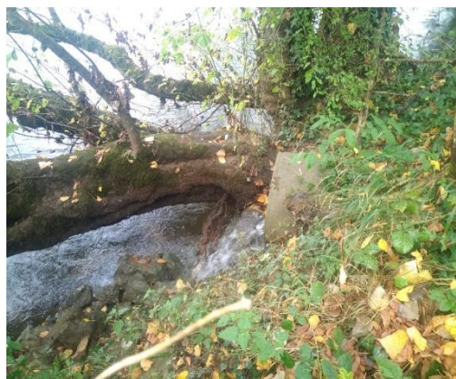
La confluence s'effectue par une buse dans la partie supérieure de la berge de la Dordogne
